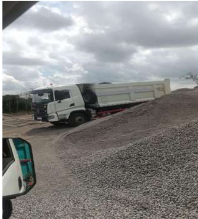
Pengambilan material di Crusher Alitta CV Alam Raya
