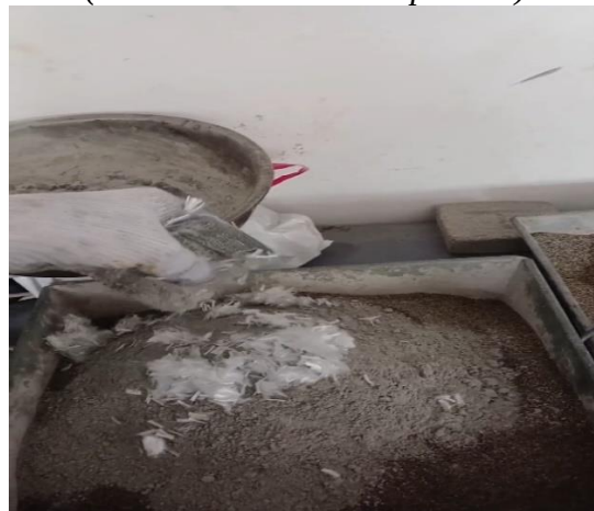
Persiapan material beton ringan (Sumber: dokumentasi pribadi)
