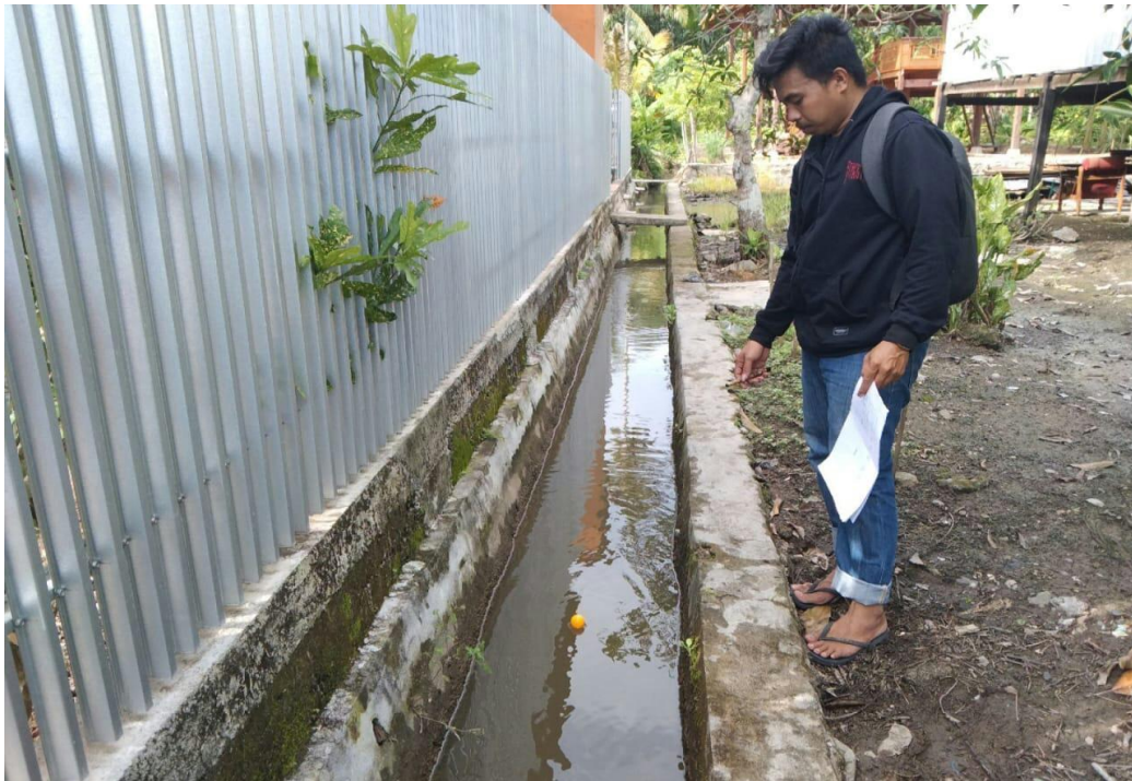
Pengukuran Kecepatan Aliran Saluran Tersier
