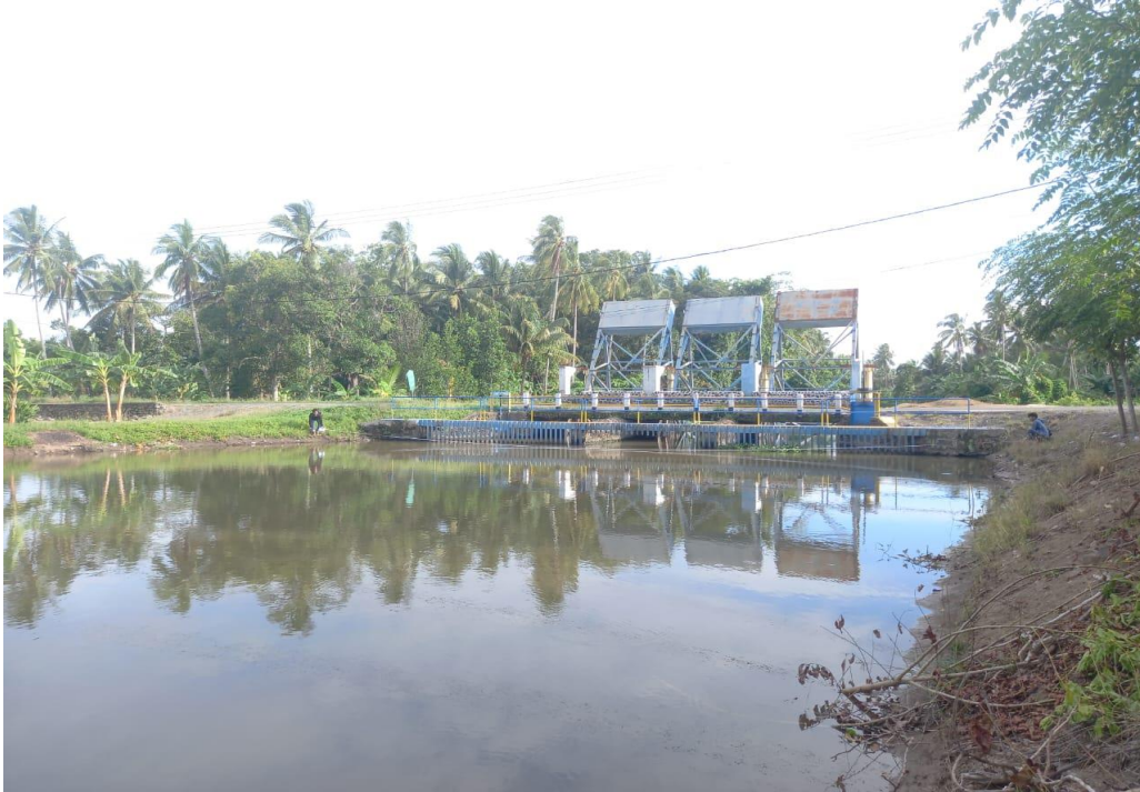
Pengukuran Lebar Saluran Primer
