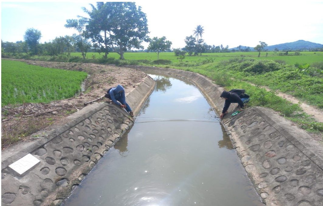
Pengukuran Lebar Penampang Basah Saluran Sekunder
