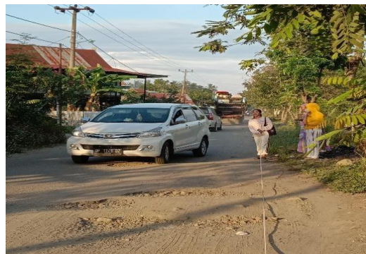
Gambar 4.11 Kondisi lalu-lintas sebelum rehabilitasi sumber: Survei lapangan
