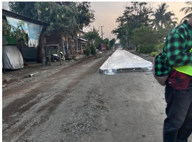
Gambar 4.20 Sebelum pengecoran Sumber: Survei lapangan
