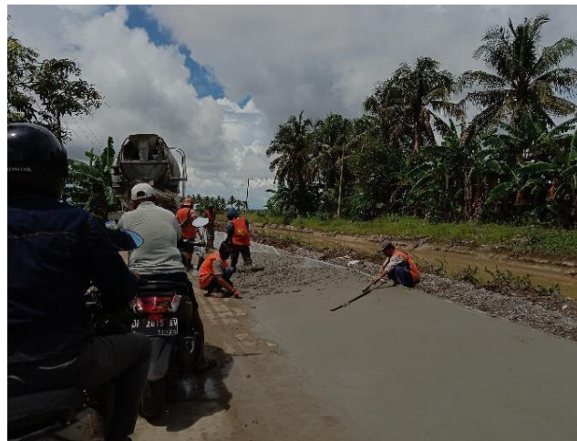
Gambar 4.21 Proses pengecoran Sumber: Survei lapangan
