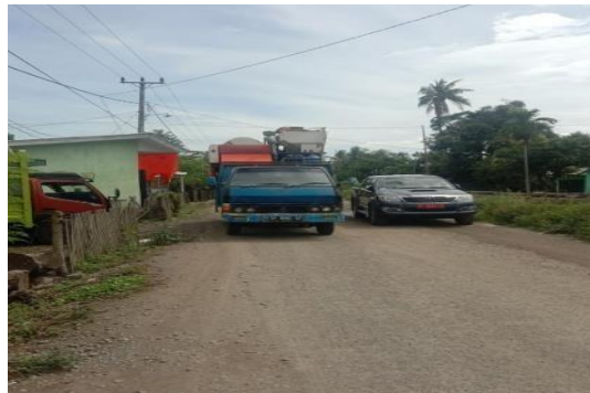
Gambar 4.10 Kondisi lebar jalan sebelum rehabilitasi Sumber: Survei lapangan
