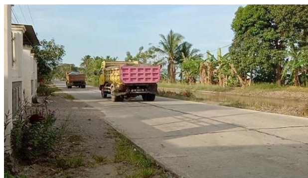
Gambar 4.15 Kondisi lalu lintas setelah rehabilitasi Sumber: Survei lapangan
