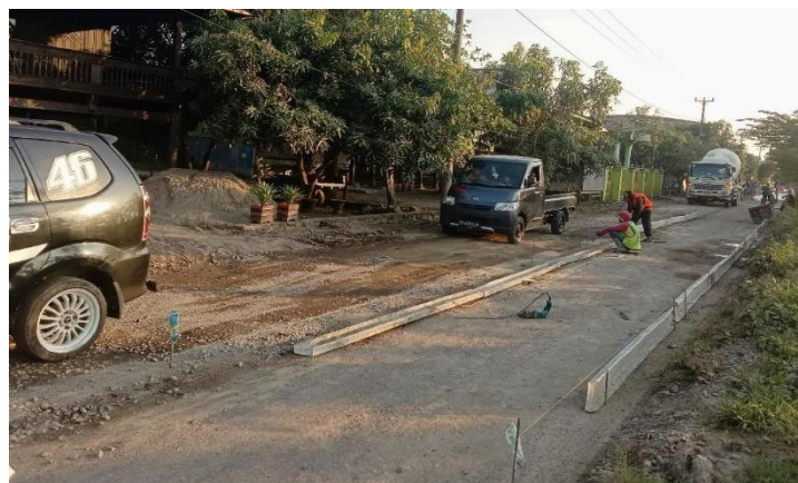
Gambar 4.19 Proses pemasangan tulangan dan bekisting Sumber: Survei lapangan
