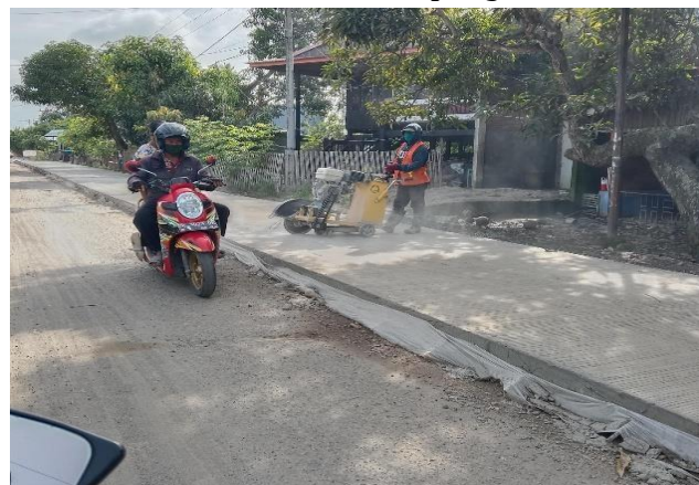
Gambar 4.22 Setelah pengecoran Sumber: Survei lapangan
