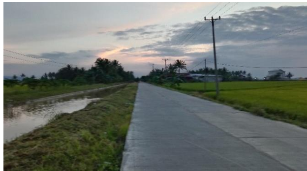
Gambar 4.13 Kondisi lebar jalan setelah rehabilitasi Sumber: Survei lapangan
