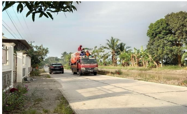
Gambar 4.14 Kondisi lalu lintas setelah rehabilitasi Sumber: Survei lapangan
