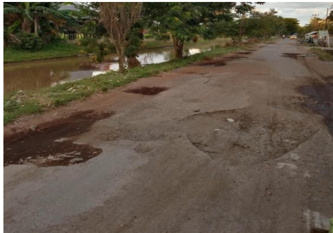
Gambar 4.3 Pengelupasan lapis permukaan Sumber: Survei lapangan
