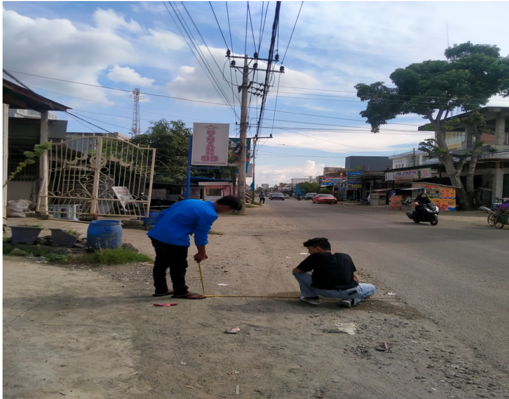
Gambar 5.7 Pengukuran Bahu Jalan
