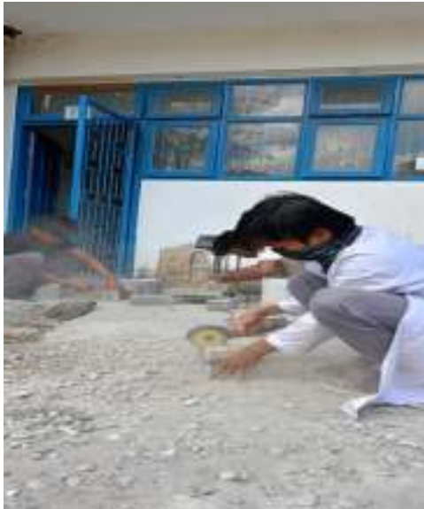
Memotong paving block balok menggunakan gerinda Sumber: dokumentasi pribadi
