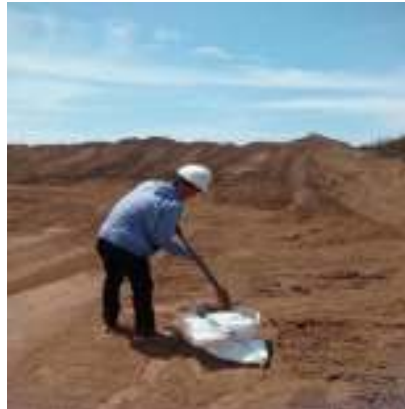
Gambar 2.7 Abu batu bara ( fly ash ) PLTU Barru Sumber: dokumentasi pribadi
