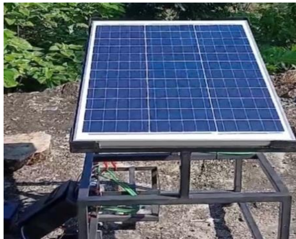
Gambar 7. Pengisian Baterai dengan Sumber Tenaga Surya
