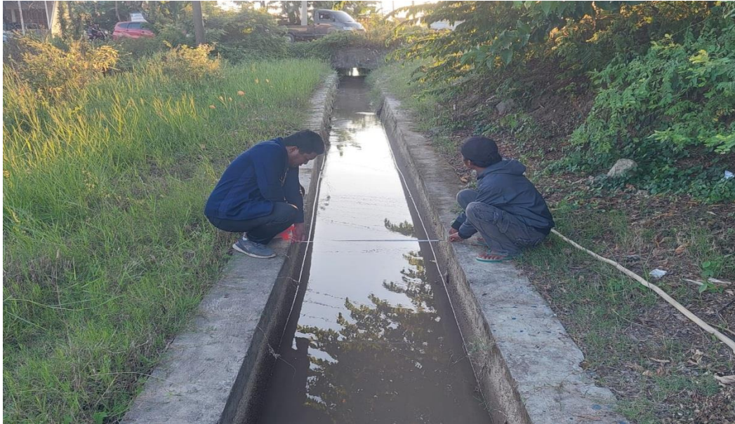
Pengukuran Lebar Saluran Tersier B.La Kiri
