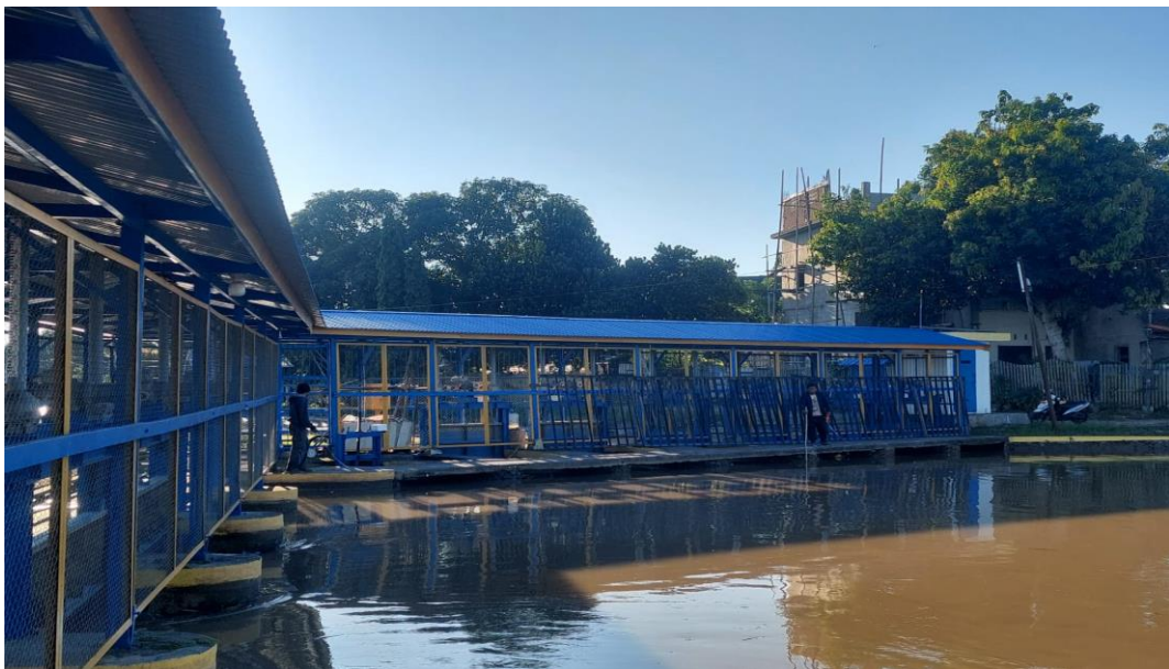
Pengukuran Tinggi Muka Air Saluran Primer
