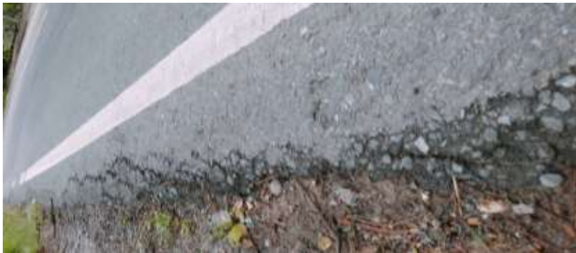
Gambar 3. 8 Retak pinggir
