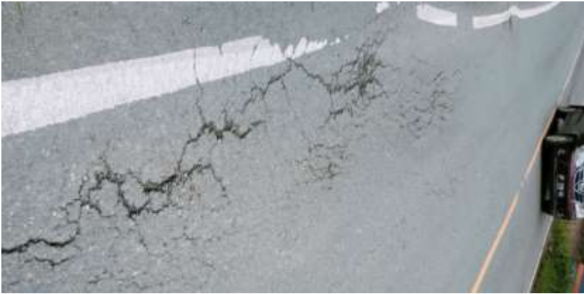
Gambar 3. 5 Retak memanjang/melintang
