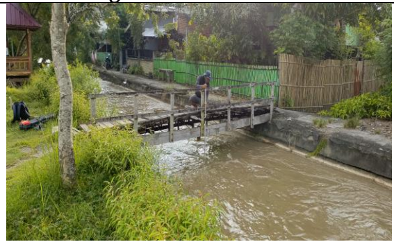
Pengambilan data kecepatan air di tengah Ruas B.Sa 10 -B.J.1
