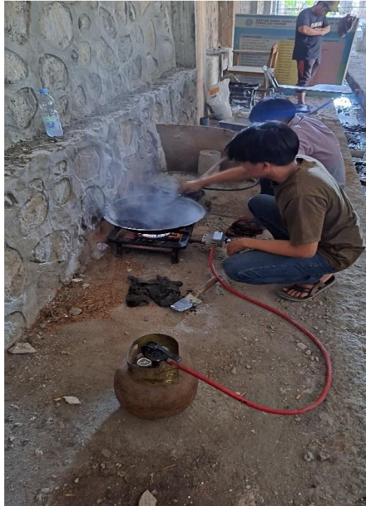
Proses pencampuran aspal dan agregat
