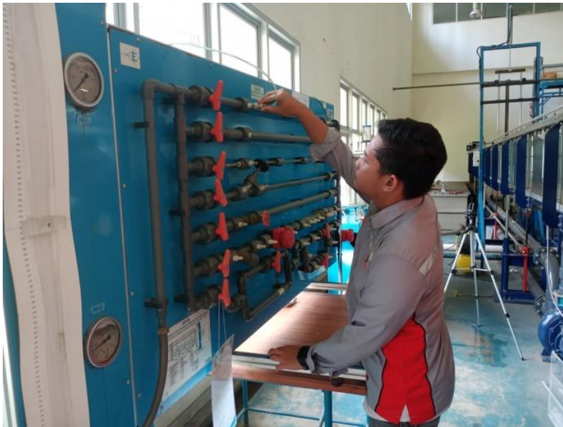
Menyambungkan alat manometer pada pipa yang diteliti
