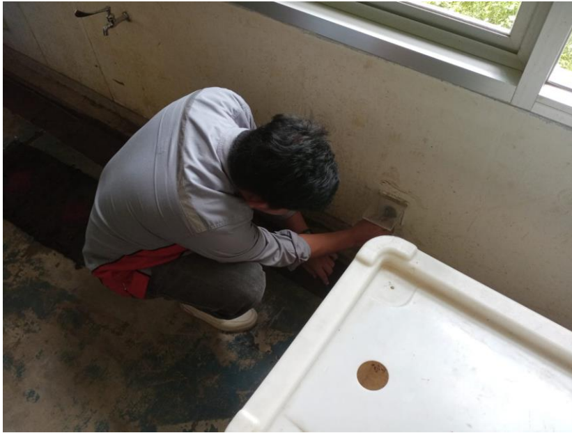
Menyambungkan aliran listrik ke mesin pompa
