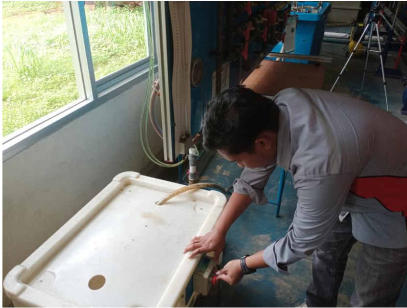
Menyalakan mesin pompa dengan menekan tombol on-off pada bak penampung
