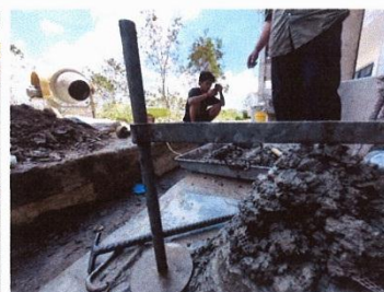
Pengukuran nilai slump
