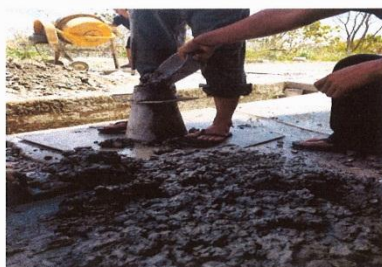
Pengujian nilai slump
