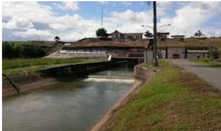
Gambar 2. 1 Saluran Irigasi Primer Bendungan Kalola Wajo (Sumber: Dokumentasi Pribadi)
