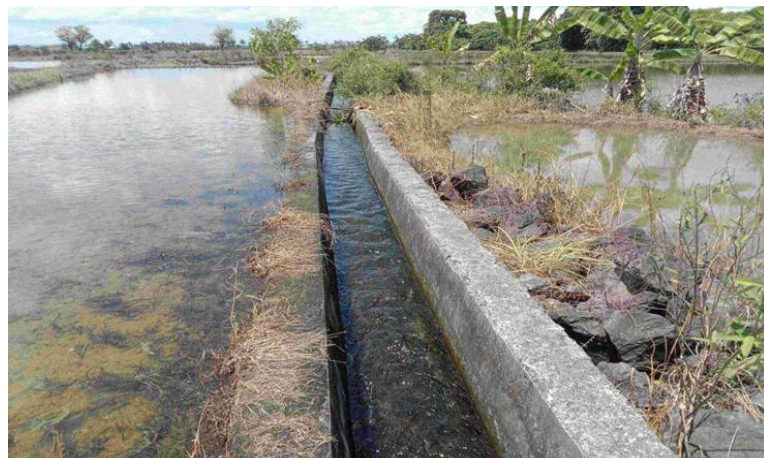
Gambar 2. 3 Saluran Irigasi Tersier (Sumber lokasi penelitian)
