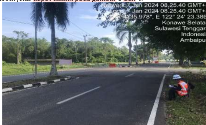
Gambar 2. Kondisi Ruas Jalan Bandara Haluoleo
