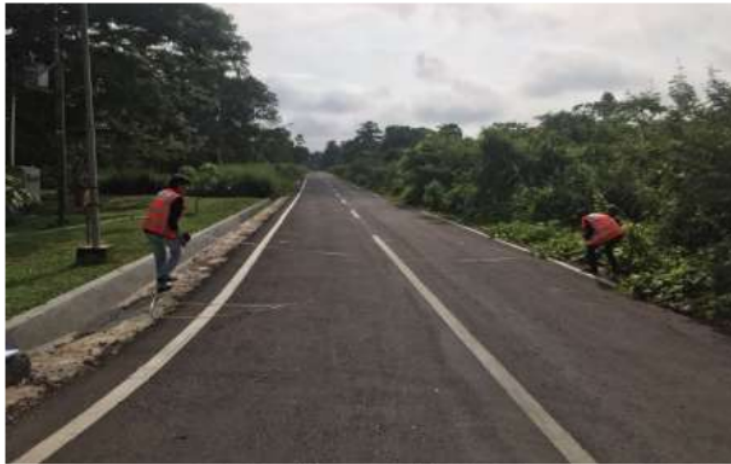
Gambar 3. Kondisi Ruas Jalan Akses DPPU Haluoleo
