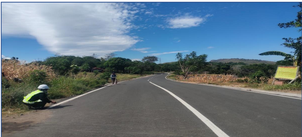
PENGUKURAN LEBAR JALAN STA 0+000
