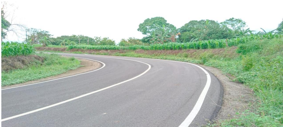
Gambar 4. 3 Kondisi Tikungan P-3 Pada Ruas Jalan Swaka Alam Lestari
