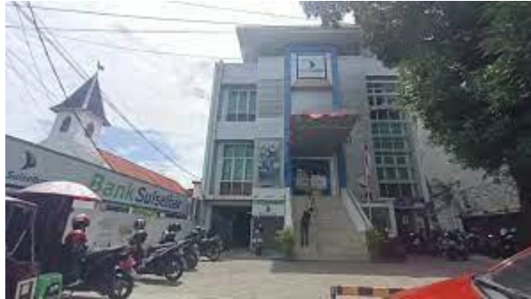
Gambar Lokasi Bank SULSELBAR Kota Parepare
