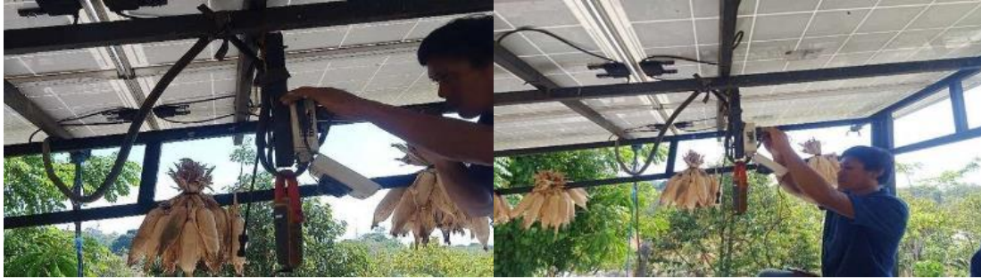
Gambar 6. Pembenahan instalasi panel surya untuk optimasi energi alternatif
