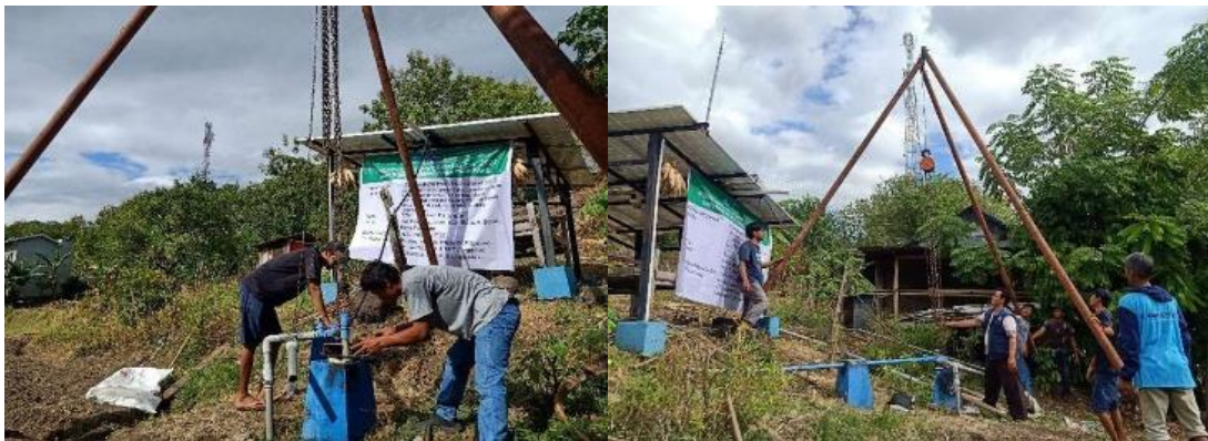
Gambar 7. Pembenahan sumur bor dan pompa air
